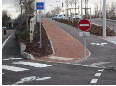
La signalisation existante « illisible »
