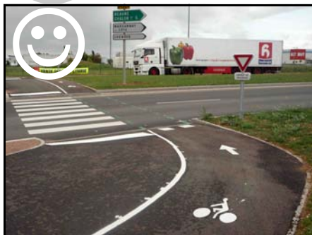
Aménagement du rond-point à l'extrémité sud du boulevard Bernard Palissy
