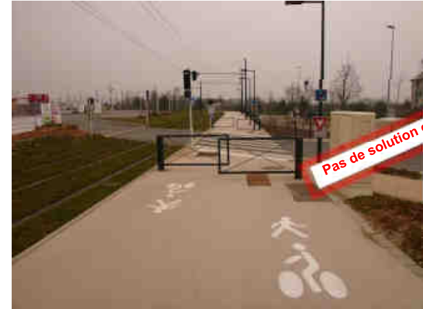
Pas de traversée cyclable matérialisée. N'est-il pas surprenant de rendre prioritaire une entrée / sortie de parking ?
