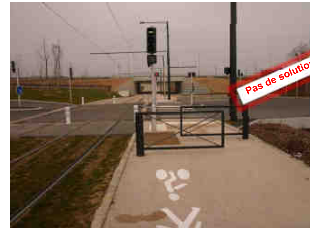
La configuration incite à contourner la chicane en passant par la plateforme
